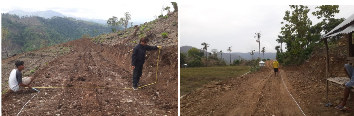
Gambar 11. Survey dan Pengukuran Jalan Long Section dan Cross Section
